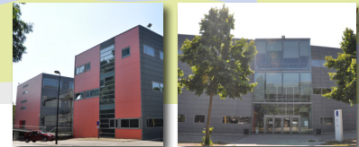
Bâtiment Erdre : n°9 Chemin de la Censive du Tertre - BP 52231 44322 NANTES CEDEX 3 Tél. +33 (0)2 40 14 17 17
