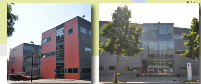
Bâtiment Erdre : n°9 Chemin de la Censive du Tertre - BP 52231 44322 NANTES CEDEX 3 Tél. +33 (0)2 40 14 17 17
